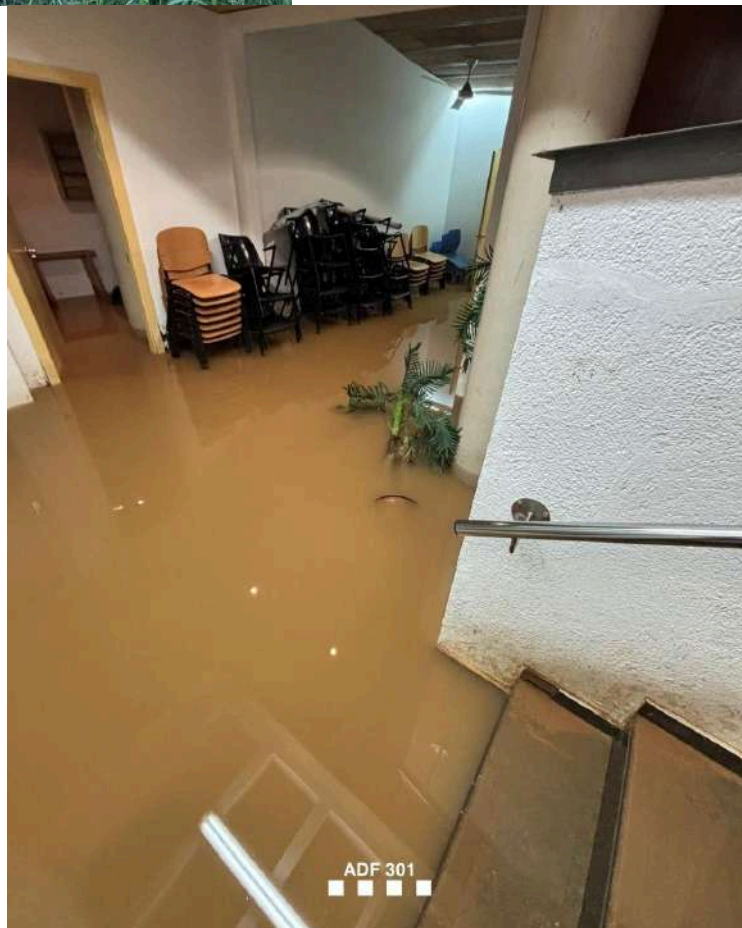
Extracció d'aigua a la Casa de la Mina
