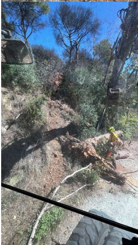
Actuació amb maquinària pesant per l'eliminació de pi caigut.
